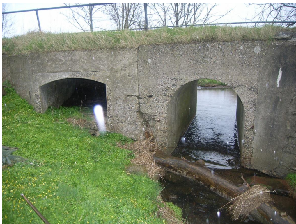
Figur 1.1: Spærring AAL-1198. Indløbsside af Ullerupvej. Venstre underløb er fra en tidligere opstemning til en møllesø og er ikke en del af vandløbet. I højre underføring er der strygende bevægelse umiddelbart efter indløbet.
